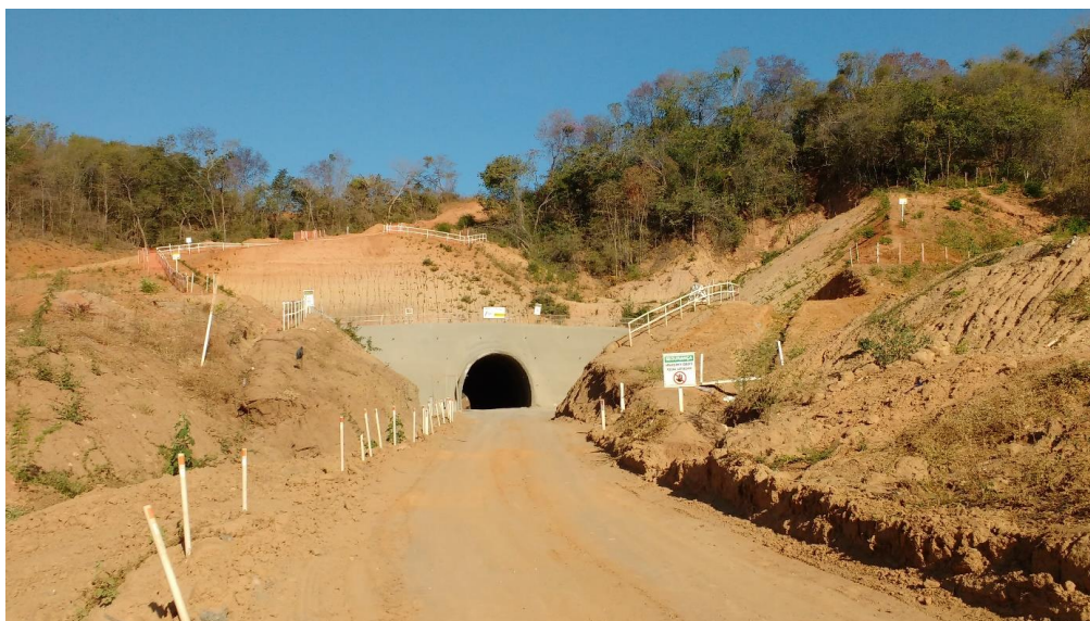
Figuras 03, 04 e 05 – Túnel Cabeceira
