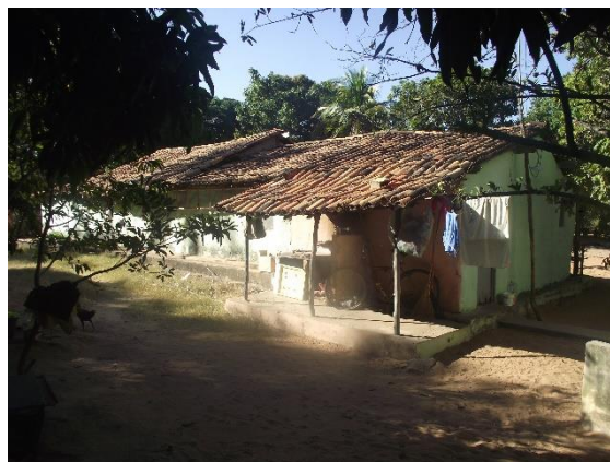
Casa na comunidade Chapada do Baixo que será atingida diretamente pelo CAC. Fonte: Foto capturada pelo autor.
