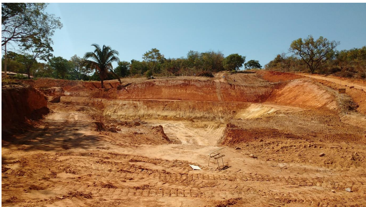
Figura 10 – Local onde será a saída do Túnel Arajara
