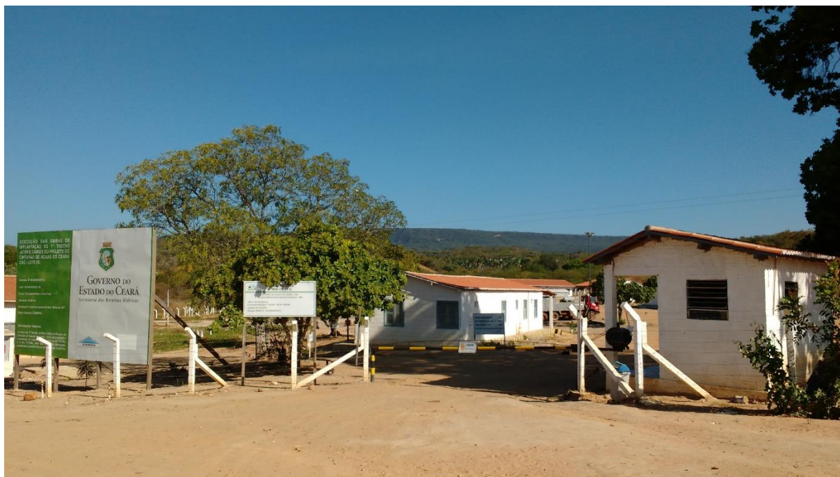
Figura 08 – Canteiro de obras no município de Barbalha, comunidade Barro Branco
