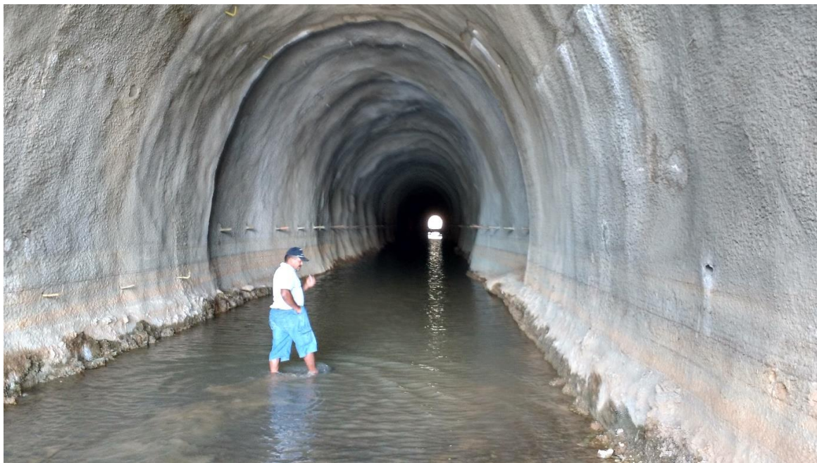
Figura 12 – Interior do Túnel Carnaúbas
