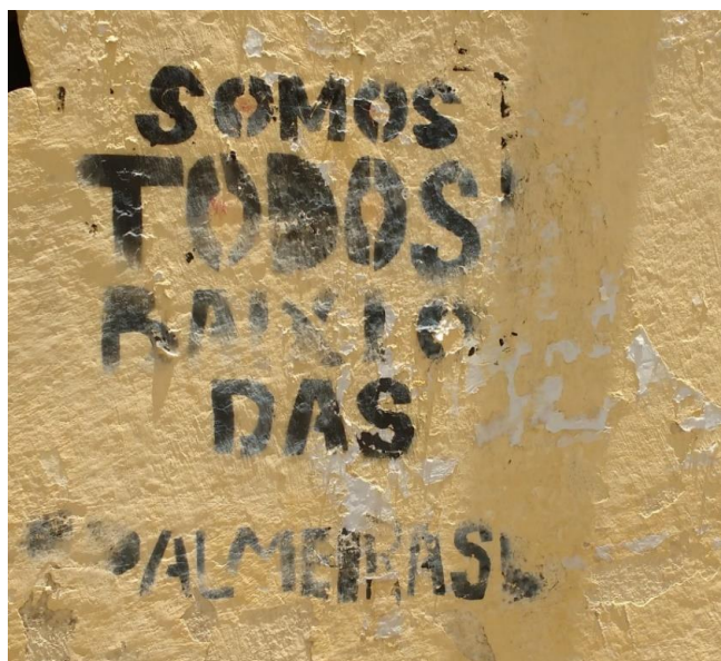
Grafite na Rua Dr. João Pessoa, que expressa apoio à luta das comunidades atingidas pelo CAC. Fonte: Foto capturada pelo autor.
