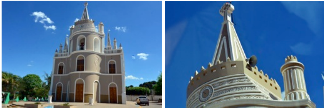
Figure 31: Igreja de Nossa Senhora do Rosário, construída por iniciativa dos escravos.
