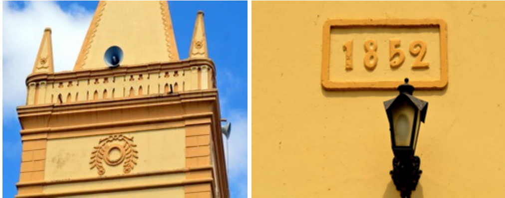
Figure 18: Detalhe de uma das torres sineiras da Igreja Matriz
